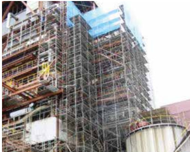
防風壁取付工事
