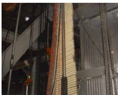
ボイラー耐圧部取替工事
