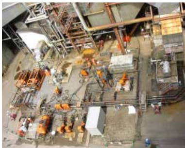
ボイラー化学洗浄配管布設工事
