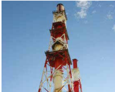
煙突塗装工事
