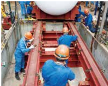
アンモニアタンク取替工事
