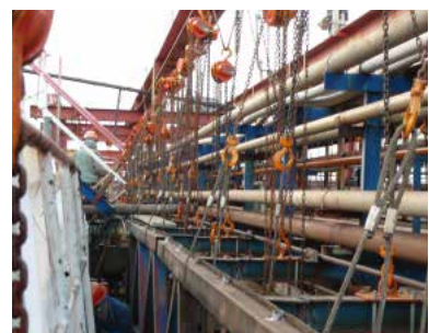
配管ラック架台取替工事
