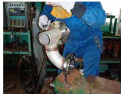
工場内架台製作・加工
