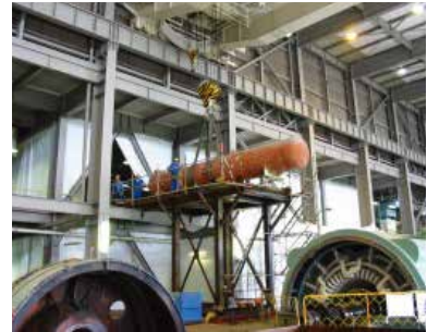
ヒーター撤去搬出工事
