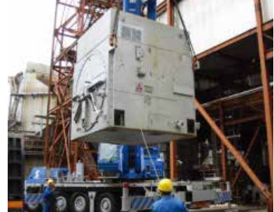
電動機据付工事
